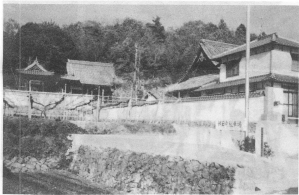
新造なった、塀・駐車場
